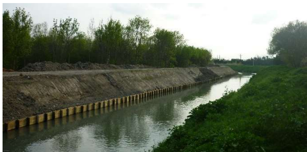
Confortement de berge à Saint Etienne du Grès
