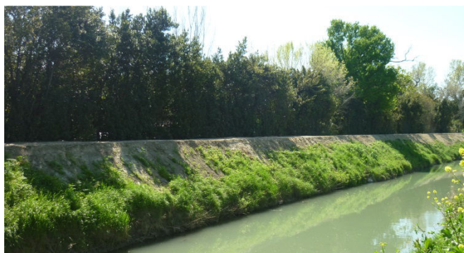
Travaux de nivellement de digue–Tarascon
