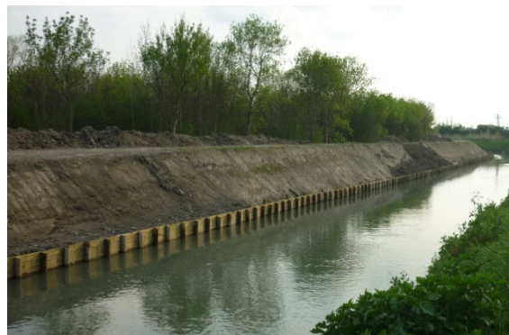
Travaux de confortement de berge-Saint-Etienne du Grès
