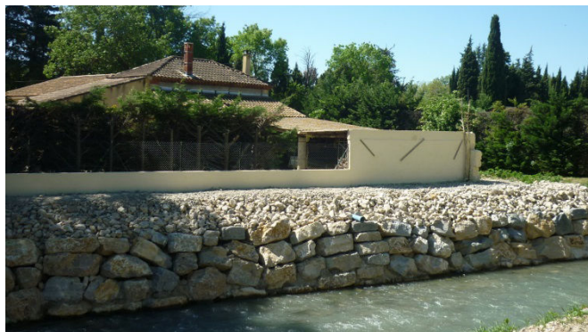
Travaux de confortement de berge -Saint-Etienne du Grès
