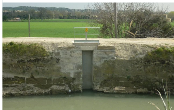
Travaux de remplacement de vanne–Fontvieille
